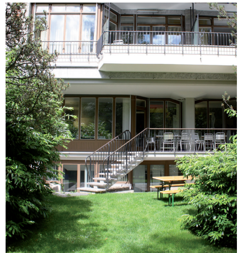
Gartenterrasse und -treppe
