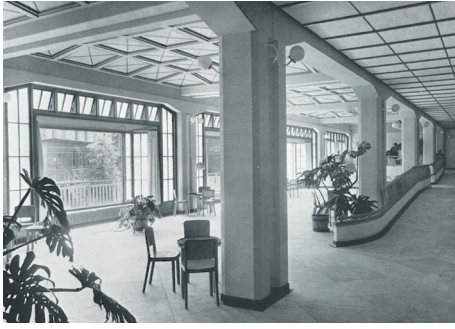
Eingangshalle im Polikliniltrakt
